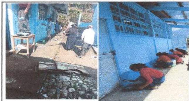
Foto 3: personas realizando trabajos de pintura en exterior e interior de la escuela
