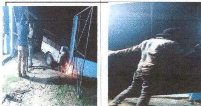
Foto 4: colocacion de porton y puertas de la dirección, puertas de la escuela
