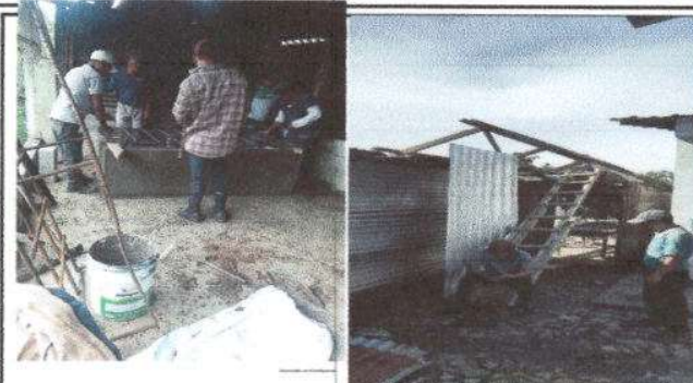
Foto 2: personas realizando trabajos en cambio de estufa y cambiando techo de cocina
