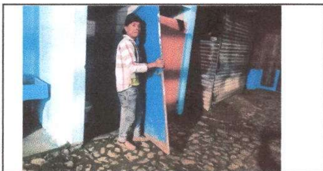
Foto 5: quitando las puertas de los servicios sanitarios
