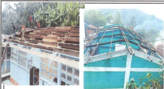
Foto1: realizando trabajos en el cambio del techo de las aulas de las dos escuelas.
